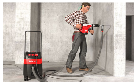
Vrtání dutým vrtákem
