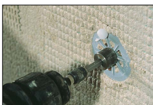
Montáž upevnění skrz zpevňovací skleněnou síťovinu
