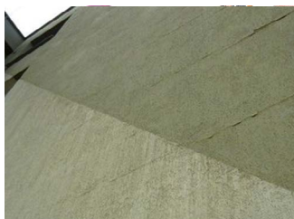
Sanace svislého posunu ETICS
