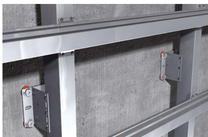
Nosné konstrukce fasád
