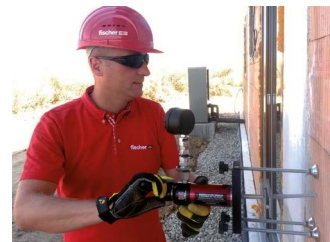
Výtažná zkouška „in situ“ na stavbě
