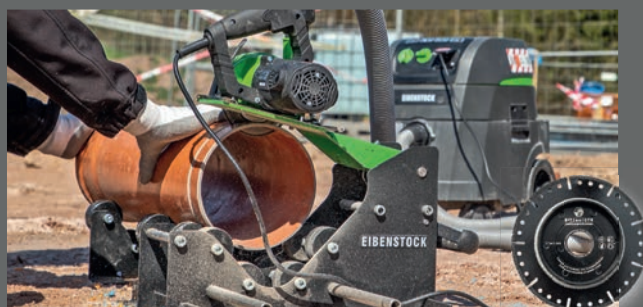
Schneiden und Fassen in einem Arbeitsgang
