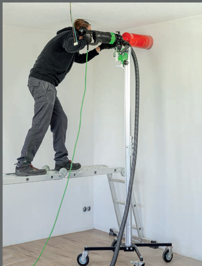
Lüftungsbohrungen bis zu 2,30 m Höhe mit Säulenverlängerung
