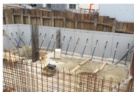
BTS M: šikmé pilíře / lešení
